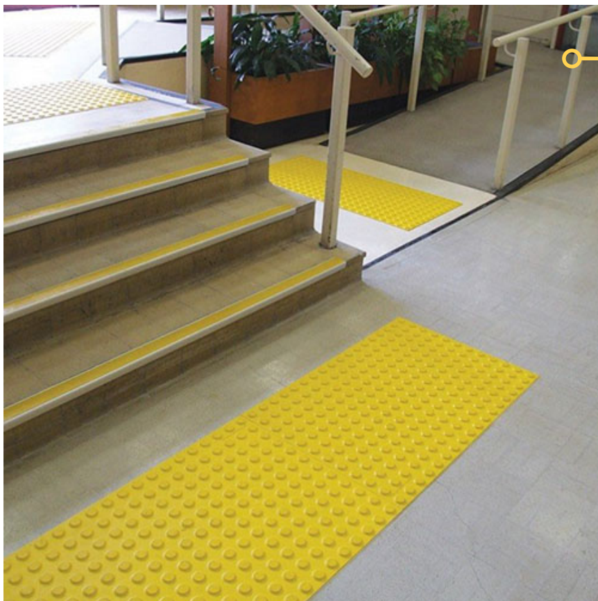
26 pav. Įspėjamasis paviršius žymi laiptų ir nuožulnos pradžia ir pabaigą.
