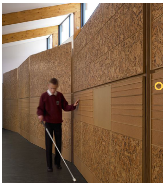
24 pav. Vedimo linijas galima įrengti ne tik vaikščiavimo paviršiuose. Čia neregys mokinytis orientuojasi mokykloje, naudodamasis baltąja lazdele ir taktiline vedimo linija, įrengta sienoje. Atkreipkite dėmesį: vedimo linija sienoje gali būti įrengta tik tuomet, kai joje nėra durų ir kitų kliūčių!
