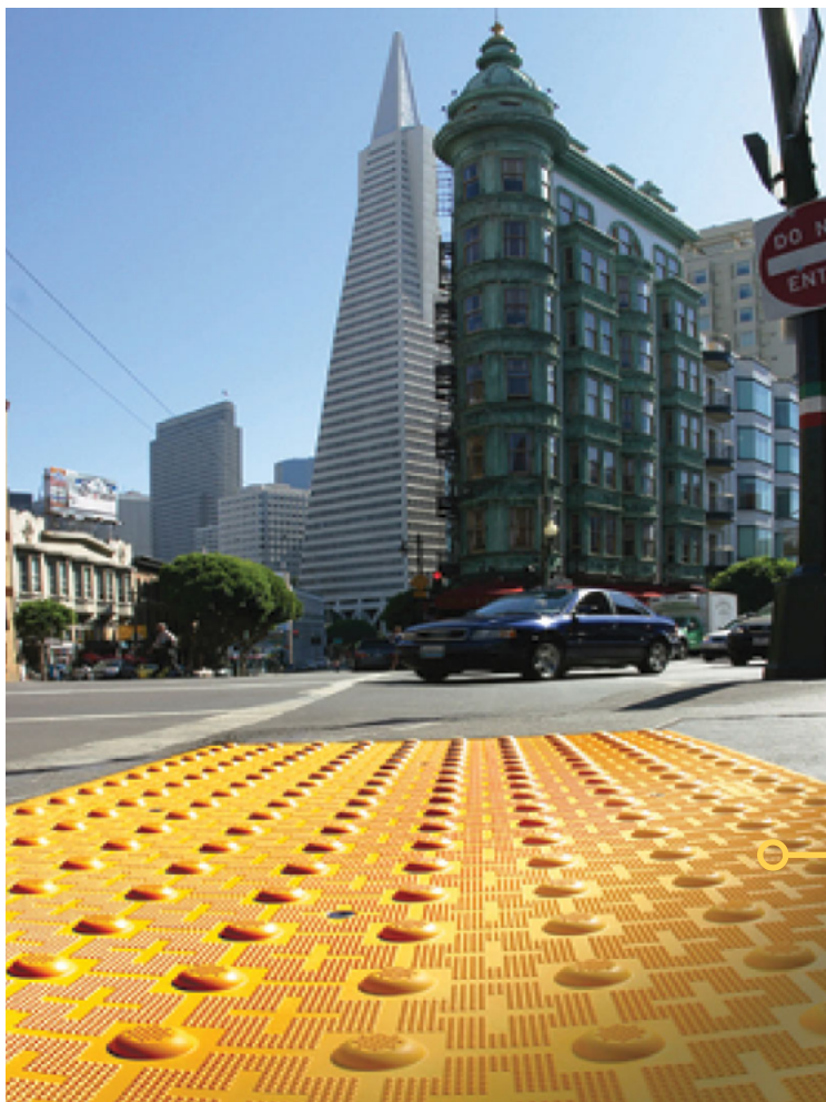
5 pav. Įspėjamasis geltonos spalvos paviršius, įrengtas pilkos spalvos šaligatvyje, vizualiai ir taktiliškai išsiskiria iš aplinkos.
