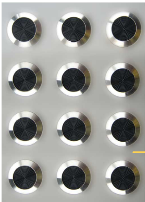
27–28 pav. Metalinių įspėjamųjų paviršių pavyzdžiai. Kairėje – metalinė stačiakampė plytelė su kaiburėliais. Kaiburėliai juodi, gerai išsiskiria šviesiai pilkame fone, tai patogu silpnaregiams. Nuotraukoje dešinėje pavaizduota, kad įspėjamieji paviršiai gali būti montuojami kiliminėje ar kitokioje dangoje iš atskirų detalių.
