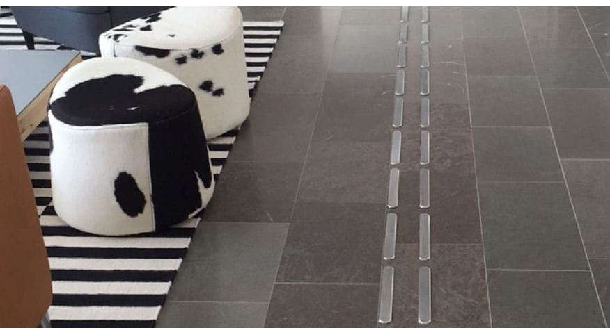
37–38 pav. Iš plieninių detalių sumontuotas vedimo paviršius. Vadinamosiose apsisprendimo vietose įrengiamas įspėjamasis paviršius.
